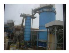
7. C'est le moment de la diffusion. Les cossettes sont plongées dans une énorme cuve d'eau chaude qui permet au sucre de passer de la cossette dans l'eau. On obtient alors du jus de diffusion. Les cossettes épuisées en sucre sont transformées en pulpe pour le bétail.
